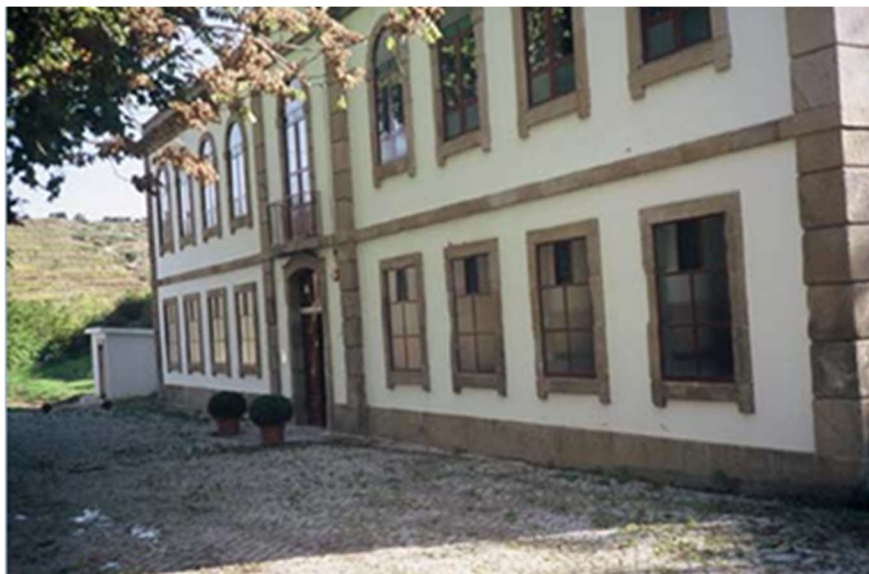
Figura 6 – O antigo edifício das Termas de Longroiva (1999).
