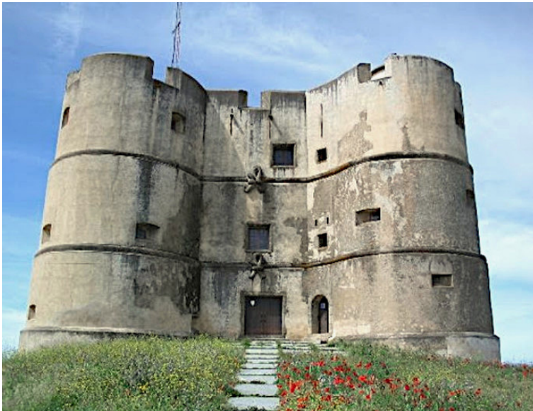
Fig. 4. Fachada da Fortaleza-Palácio de Évora Monte, com a empresa do nó
