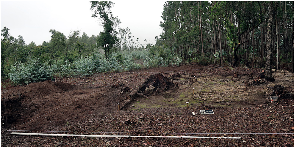
Fig. 5. Plano inicial dos trabalhos em 2021, na zona do telégrafo
