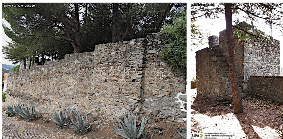
Fig. 2. Pano de muralha (a sul) sendo visível o remate escalonado e vista de ângulo da face interior do cubelo Fonte: Fotografia de Paula Noé, 2010 (SIPA FOTO 01006260 e 01006264) apud NOÉ, 2013a
