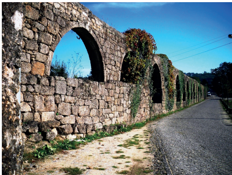
Fig. 3 Aqueduto do Mosteiro de Bustelo
