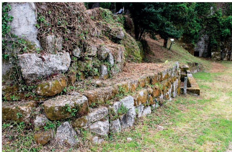
Fig. 12 Troço do aqueduto que segue da cozinha para a fonte da horta
