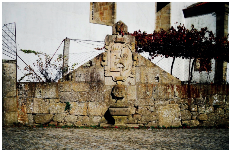
Fig. 10 Fonte junto à estrada
