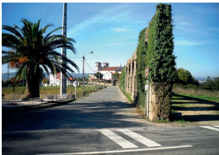
Fig. 1 Vista do aqueduto e do Mosteiro
