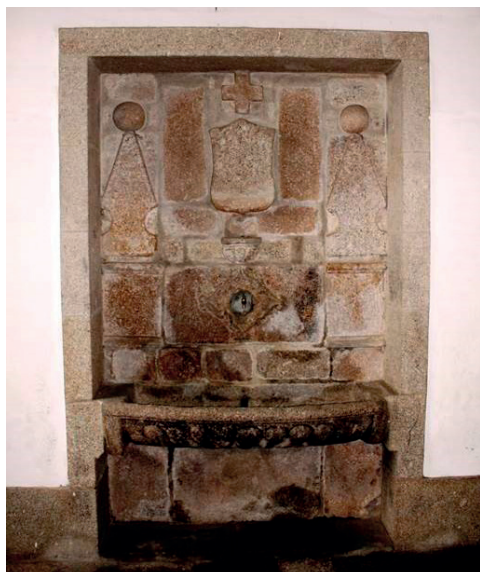
Fig. 4 Lavatório à entrada do refeitório
