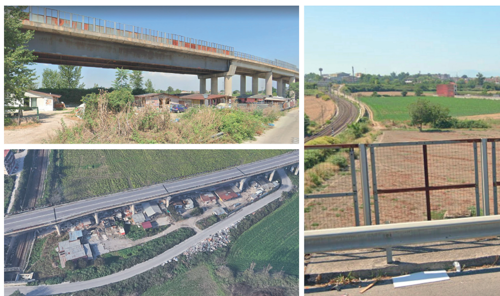
Fig. 3. Immagini da Google Maps della strada SP527
