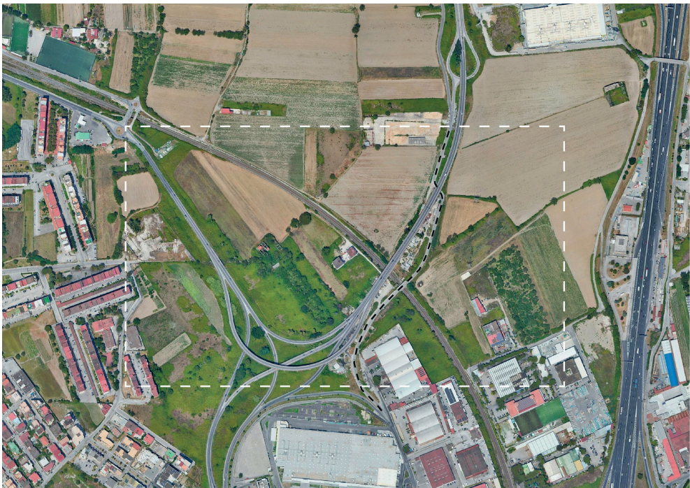
Fig. 1. Foto aerea di un tratto della SP527. Fonte: © Google
