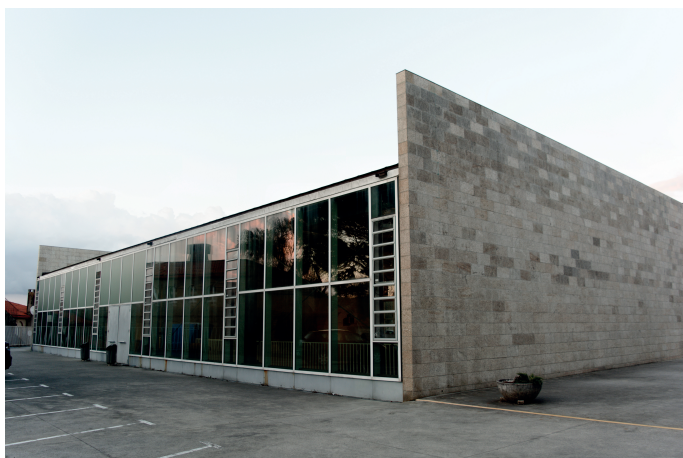
Fig. 4 Josef Paul Kleihues, Pavilhão desportivo de San Clemente (1990–1993) Fonte: Fotografia do autor tirada em setembro de 2020
