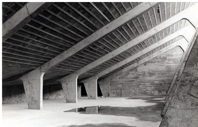
Fig. 28. Centro de Convivência Cultural de Campinas, vista interior com colunas e vigas de sustentação da bancada, 1973 Fonte: Casa da Arquitectura. Coleção fotográfica do Centro de Convivência Cultural, em Campinas (fotografia n.º 97, PT_CA_ABR_1_A28-02-0097)
