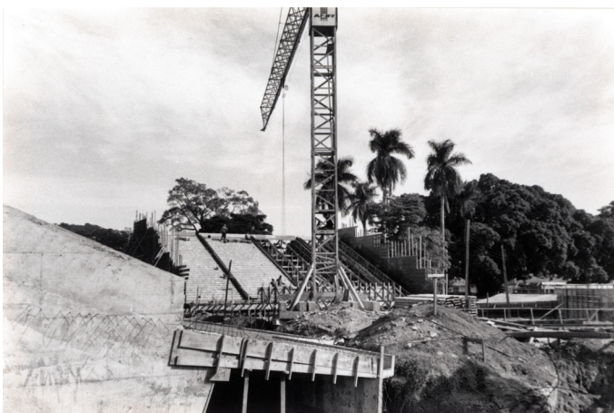
Fig. 25. Centro de Convivência Cultural de Campinas: obra e estruturas, 1968 Fonte: Casa da Arquitectura. Coleção fotográfica do Centro de Convivência Cultural, em Campinas (fotografia n.º 16, PT_CA_ABR_1_A28-02-0100)
