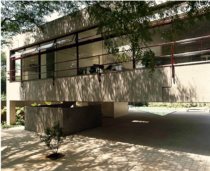
Fig. 50. Fachada da Casa Gerassi Fonte: Casa da Arquitectura. Coleção de Arquitectura Brasileira, PT_CA_ABR_PMR3-02.01.4-0058
