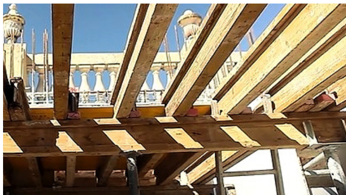
Fig. 65. Captura digital extraída do vídeo A estrutura preexistente em fase de reabilitação e reforço para a construção do novo espaço , 2015 Fonte: CASA DA ARQUITECTURA, prod. , 2018a: captura (00:02:19)
