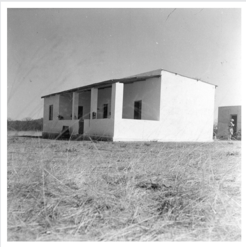
13: Lugar da Tunda, Chiengo (Gambos), distrito da Huíla. Casa de Michel Prinsloo, filho, acabada de construir.
