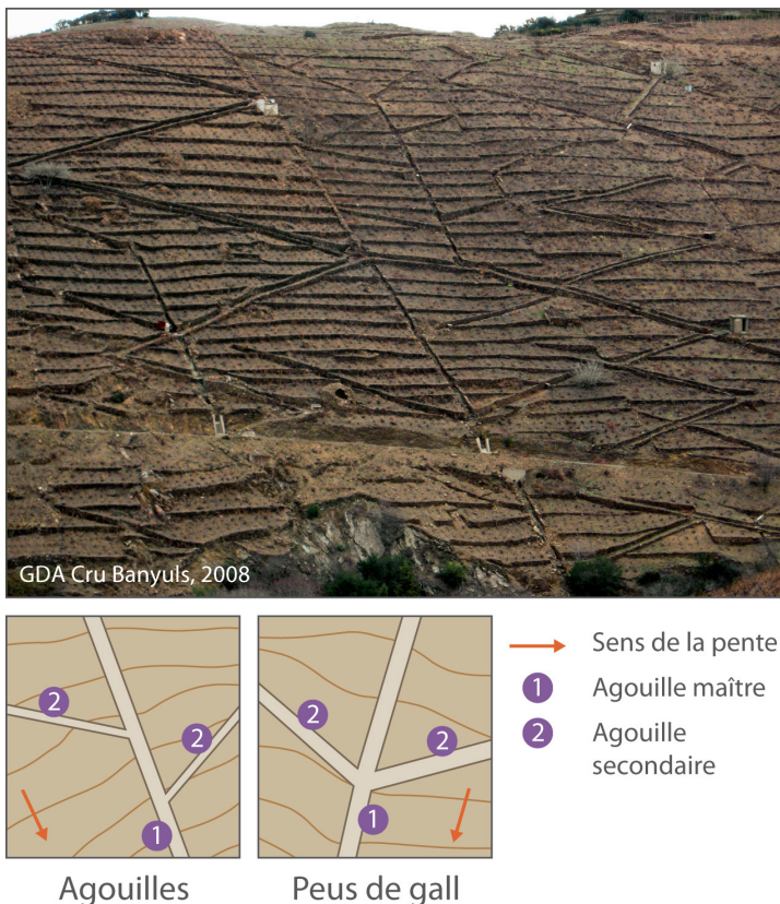
Fig. 2. Les aménagements des versants en «Peus de gall». Réalisation : R. Crouzevialle, F. Cerebelaud, d'après GILLES, 2010
