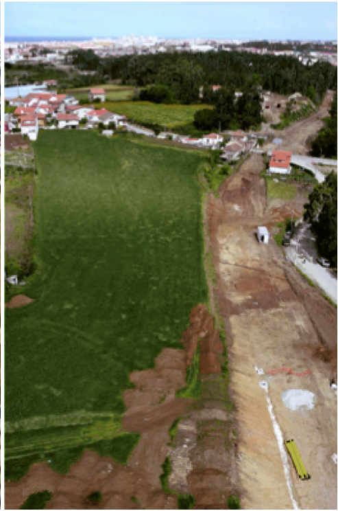
Fig. 2. Vista aérea parcial da estação do Corgo, em foto tirada de sul para norte, observando-se o Fosso I antes da sua escavação (2005)
