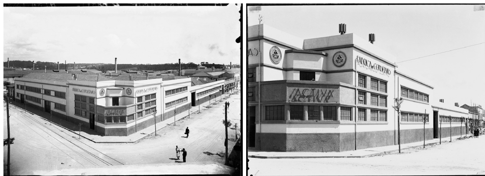
Figs. 3 e 4. Fábrica Activa, fachada principal. Fonte: Foto Alvão. CPF-ALV-028969 e 289970
