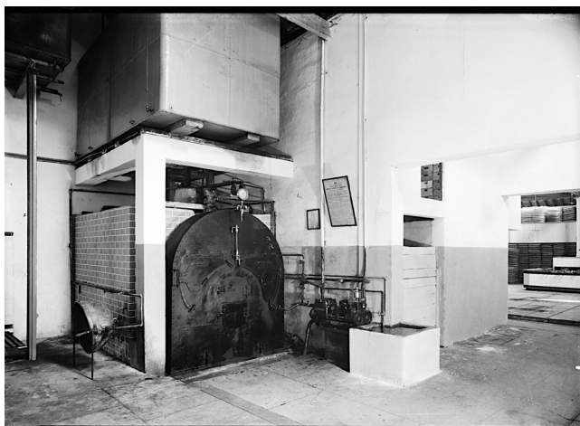
Fig. 6. Casa da caldeira Fonte: Foto Alvão. CPF-ALV.004 480
