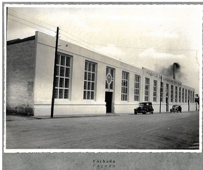
Fig. 2. Fachada principal da fábrica A Boa Nova Fonte: «Álbum fotográfico» de A Boa Nova (anos de 1930) 34
