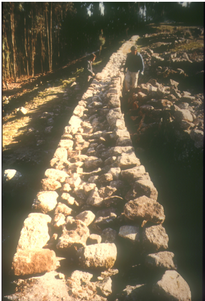
Figura 6— Muralha do recinto superior do Monte Mozinho, Penafiel, em decurso de limpeza e conservação, em 1998. Esta muralha, construída em época augústea, apresenta uma largura modesta, notando-se que o seu enchimento interior foi executado com pedra seca.
