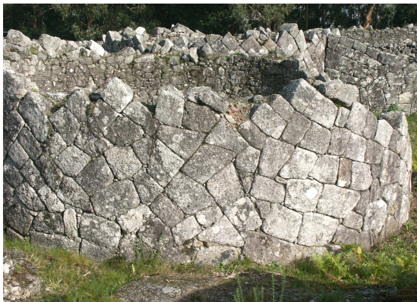
Figura 7— Elemento de um núcleo familiar da Citânia de Santa Luzia. Aparelho poliédrico muito irregular mas de excelente talhe, com assentamento a seco, e raro recurso a pequenas cunhas. Em contraste com este rigor de execução, note-se a composição da face interior da construção, em segundo plano, composta por pedras mais pequenas e irregulares.
