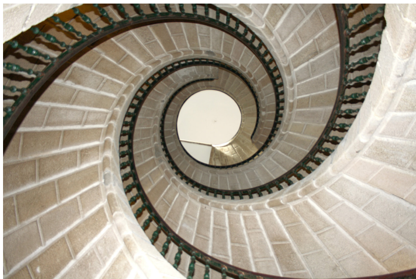
Fig. 6. Domingo de Andrade. Escalera de triple espiral volada. Convento San Domingos de Bonaval. 1695.
