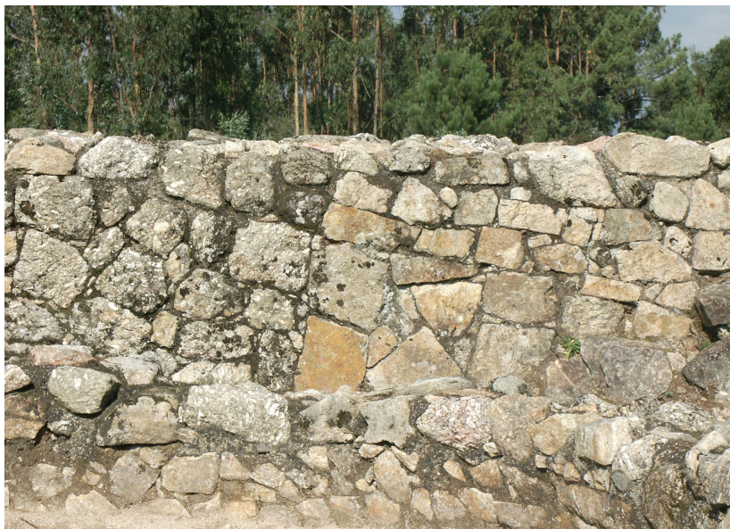
Figura 9— Face interior da muralha do recinto superior do Monte Mozinho. O alinhamento vertical do encontro de dois tramos que utilizam pedra de diferente proveniência e aparelhos ligeiramente desiguais, sugere que cada um dos tramos terá sido executado por uma equipe diferente, e ambas convergiram para este ponto.
