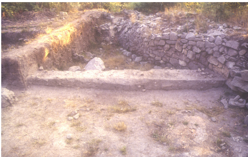
Figura 4— Castro de Penices, Gondifelos, Vila Nova de Famalicão. Vista geral da face interior da segunda fase da muralha, correspondente ao seu alargamento. Note-se a distorção acentuada do seu alinhamento e prumo, com indicio de ter sido construída com inclinação, para contrafortar a carga do enchimento.
