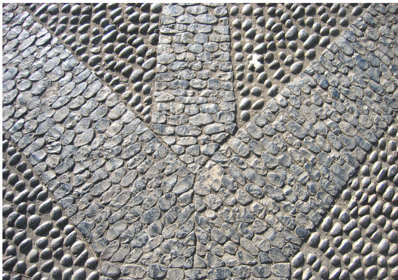
Figura 5 – Pormenor da Calçada Madeirense, do Parque de Santa Catarina, no Funchal, que permite observar a aplicação de seixos inteiros e de seixos partidos pela metade. © João Baptista, 2022
