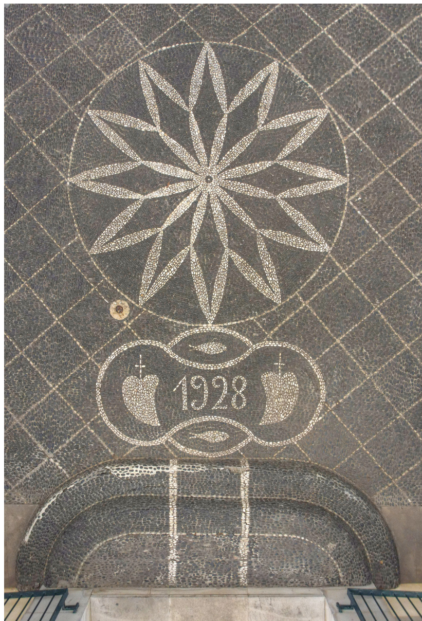
Figura 6 – Perspetiva aérea sobre o pavimento em Calçada Madeirense existente na entrada sul do adro da igreja de Nossa Senhora da Piedade, Porto Santo, permitindo observar a aplicação de vários motivos geométricos e religiosos. © Fábio Brito, 2023
