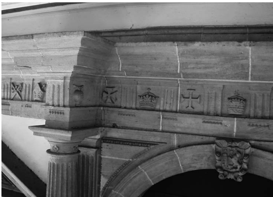
Fotografia 02 – Trecho do entablamento do pórtico da Igreja São Sebastião da Bahia.
