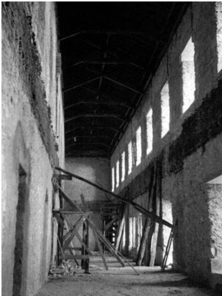
Fig. 16 - Interior da ala do dormitório durante as obras
