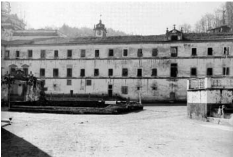
Fig. 15 - A ala do dormitório antes das obras
