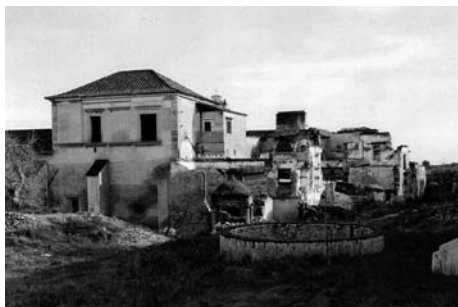
Fig. 8 - A ala nascente antes do restauro
