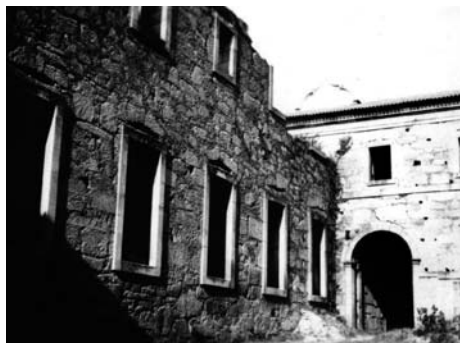
Fig. 2 - O corpo intermédio antes das obras
