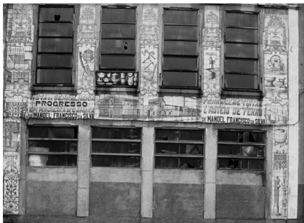
Fig. 4 – Revestimento da fachada posterior da Serralharia Progresso. Rua n.º 8, Espinho.
