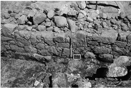
5 - Aspecto do alçado exterior da muralha
