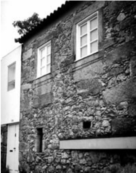
Casa do arquitecto Correia Fernandes
