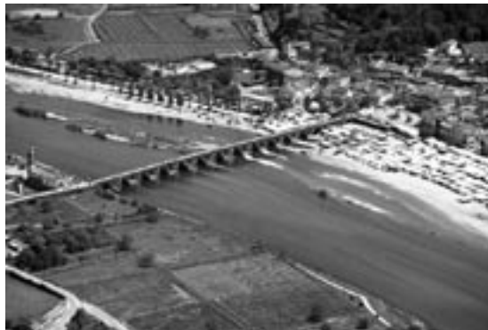
Figura 3 – A ponte de Ponte de Lima.
