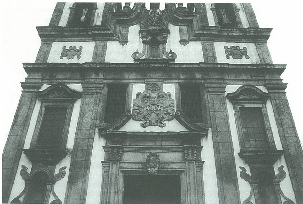
Fig. 2 – Vila Real. Igreja de São Pedro. Pormenor da Fachada.
