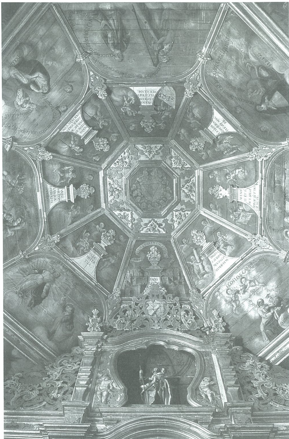
Detalle de la techumbre
