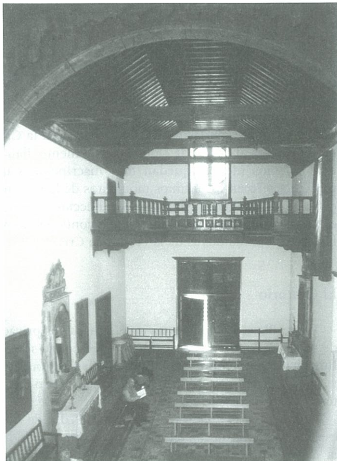
Nave de la Capilla
