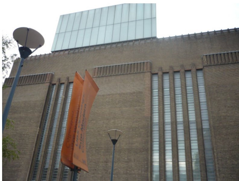
Fig. 1. Detalle de la fachada principal de la Tate Modern de Londres.
