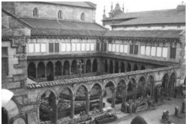
Foto n.º 1 - Exterior do Museu
