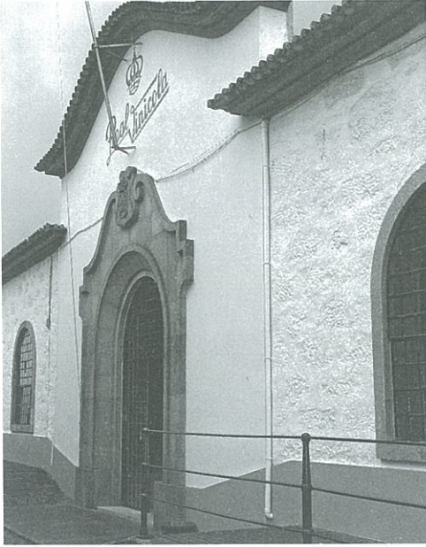
Fig. 2 | Instalações da RCUNP
