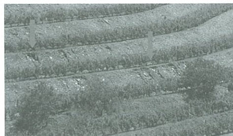
Foto n.º 3 | Ravinamentos nos taludes de uma vinha em patamares (Sobreira, Murça), após precipitação intensa de 7/06/04.
