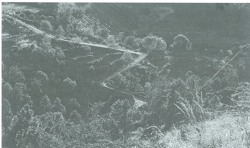
Fig. 7 | Estrada e ponte ditas romanas sobre o Rio Trovela - Murça
