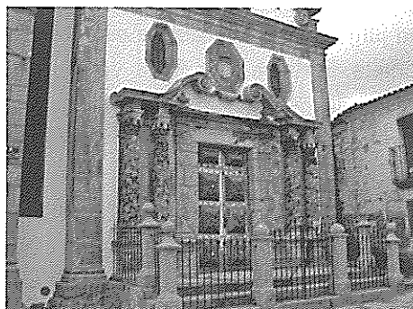
Fig. 3 | Capela da Misericórdia de Murça – Portal
