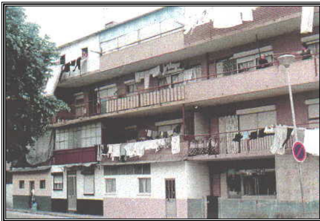
Fotografia 46 – Varandas de acesso aos alojamentos fechadas sem qualquer uniformização, no Bairro de S. João de Deus
