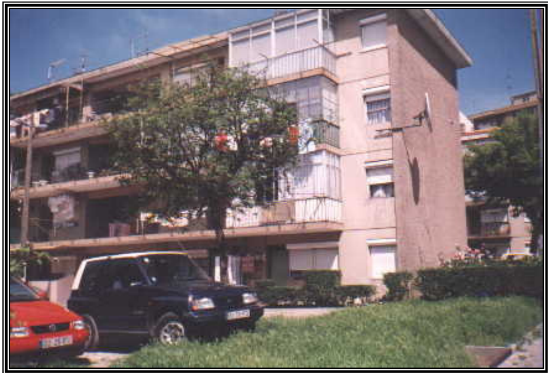
Fotografia 45 – Varandas de Acesso aos alojamentos fechadas, no Bairro de Fernão de Magalhães
