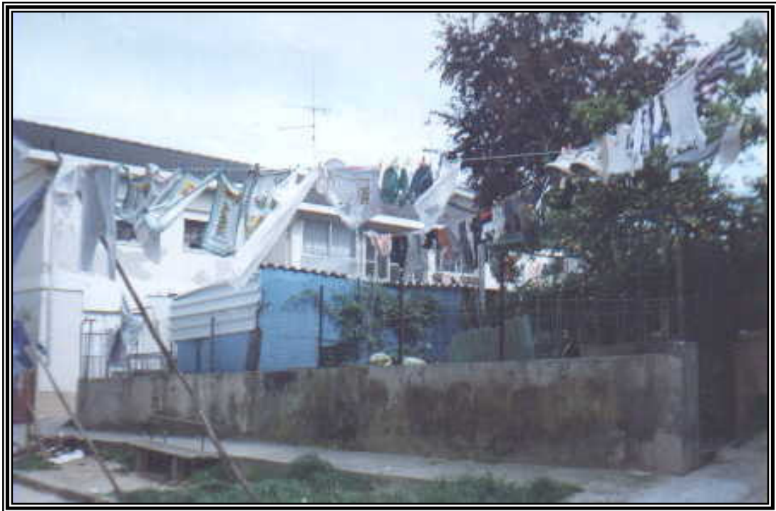
Fotografia 75 – Anexos construídos nas traseiras para arrecadação e roupas penduradas no exterior do Bairro
