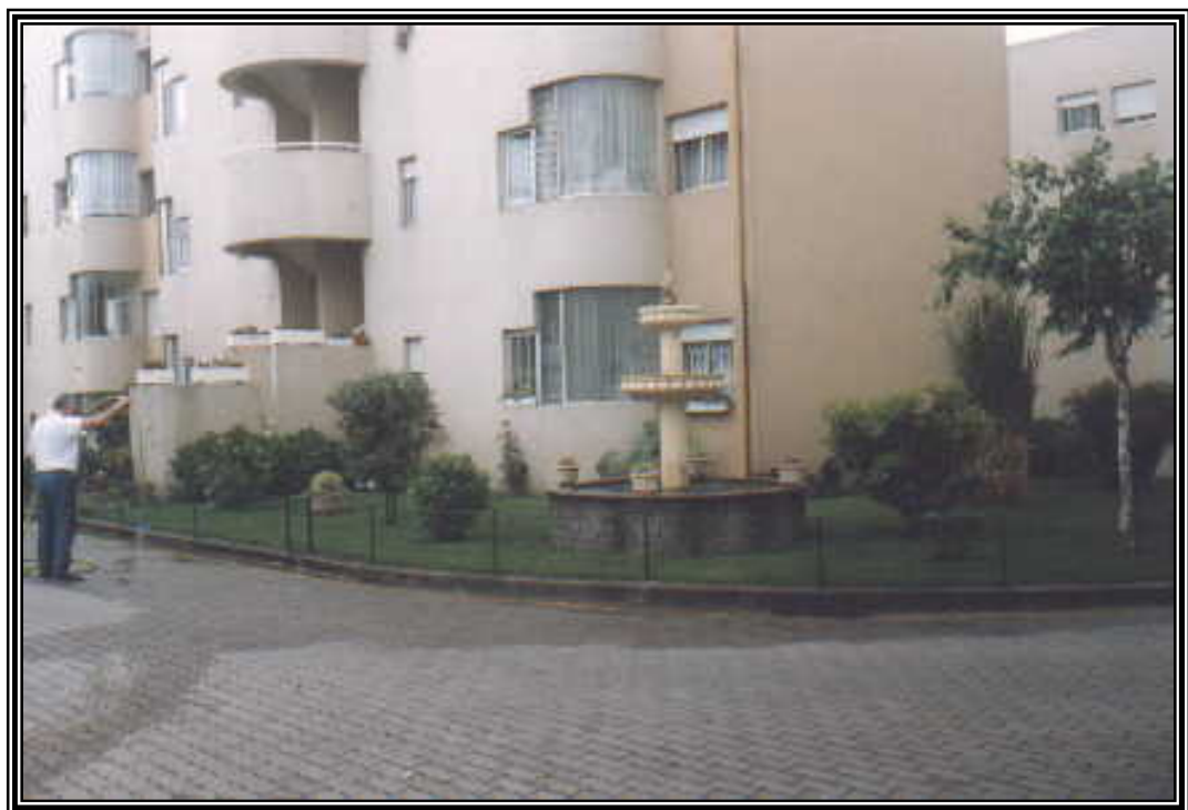
Fotografia 81 – Jardim fronteiro aos edifícios, com fonte
