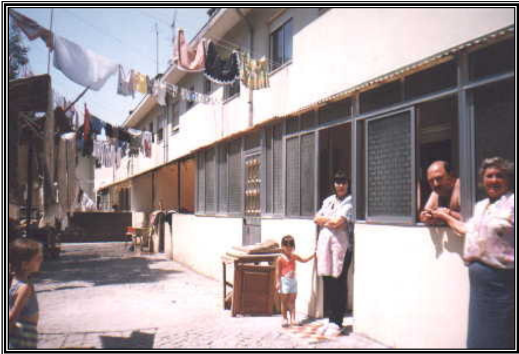
Fotografia 48 – Construção de varandas fechadas no rés-do-chão, no Bairro do Cavaco
