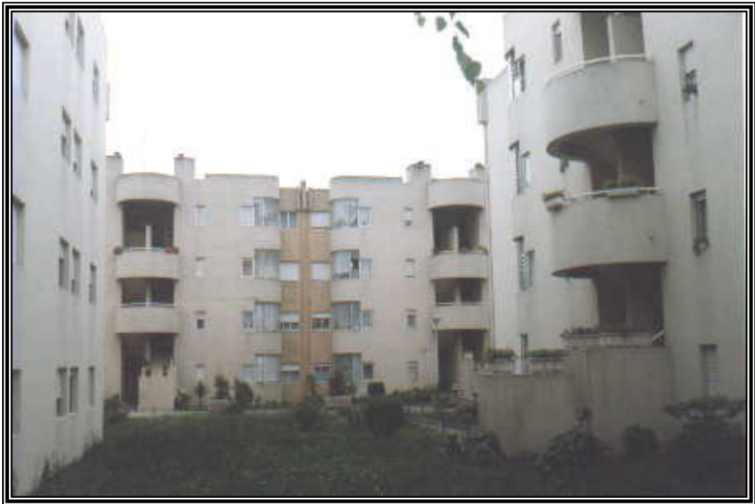
Fotografia 15 – Bairro de Sta Luzia edifícios arrendados (Paranhos – C.M. do Porto/INH)
