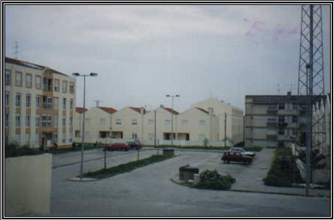
Fotografia 17 – Bairro das Cabanas moradias e edifícios plurifamiliares (Rio Tinto C.M. de Gondomar/INH)
