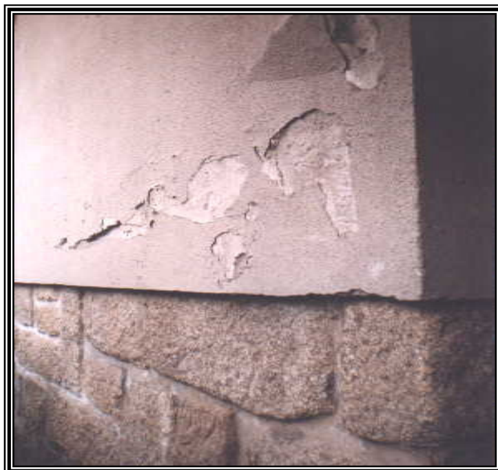
Fotografia 51 – Marcas de degradação nas paredes exteriores, no Bairro de Fernão de Magalhães
