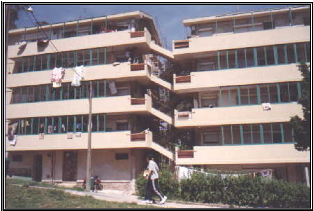
Fotografia 2 – Bairro da Pasteleira, edifícios tipo B, Plano de Melhoramentos (note-se que as galerias de acesso aos alojamentos estão a ser fechadas devido às obras de reabilitação)
