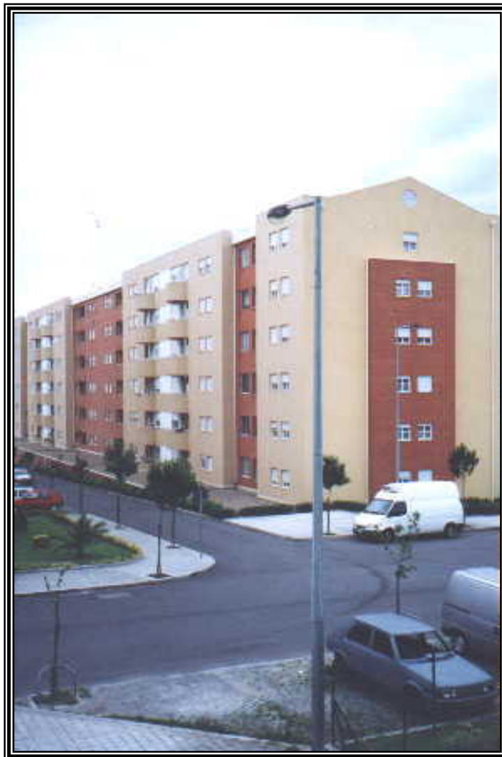
Fotografia 13 – Quinta do Meilão Edifícios Municipais (Águas Santas – C.M. da Maia/INH)
