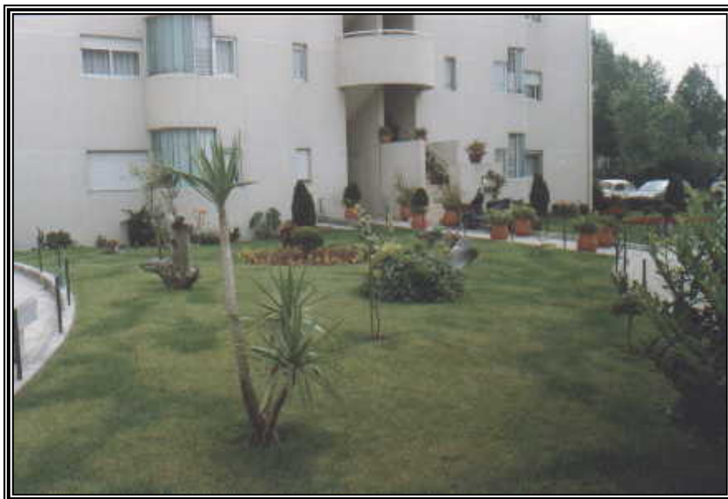
Fotografia 79 – Jardim fronteiro, com pequena fonte e vasos de plantas na entrada e acessos ao edifício
