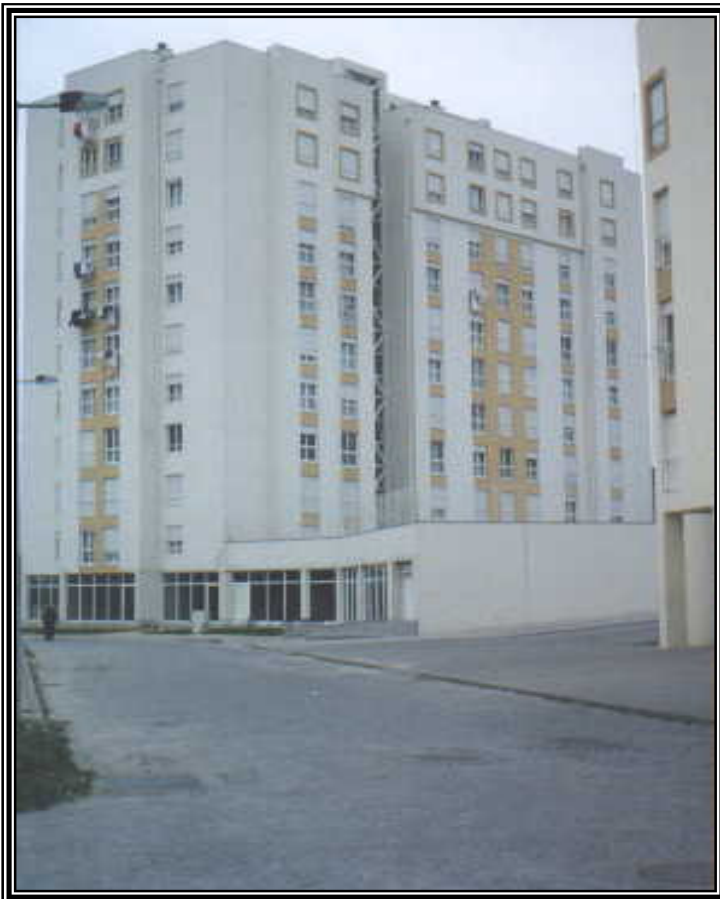
Fotografia 18 – Bairro das Cabanas, torre
