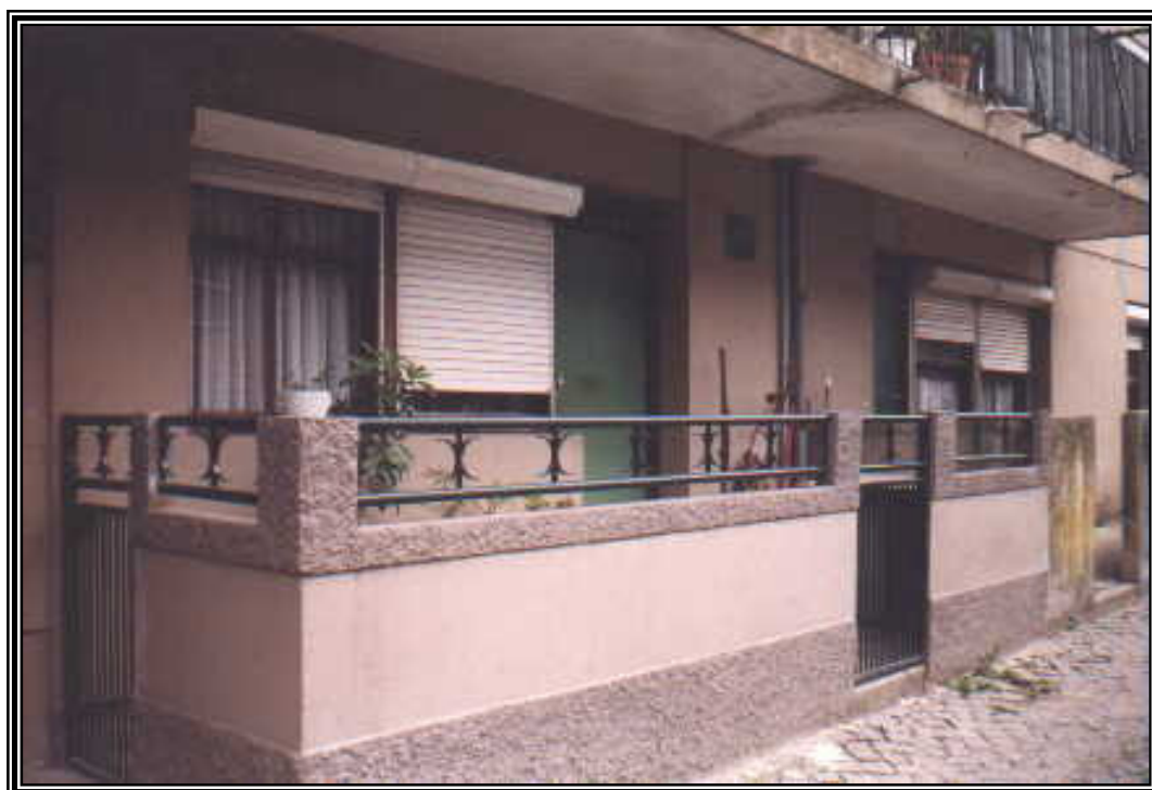
Fotografia 47 – Construção de varanda no rés-do-chão, no Bairro de Fernão de Magalhães
