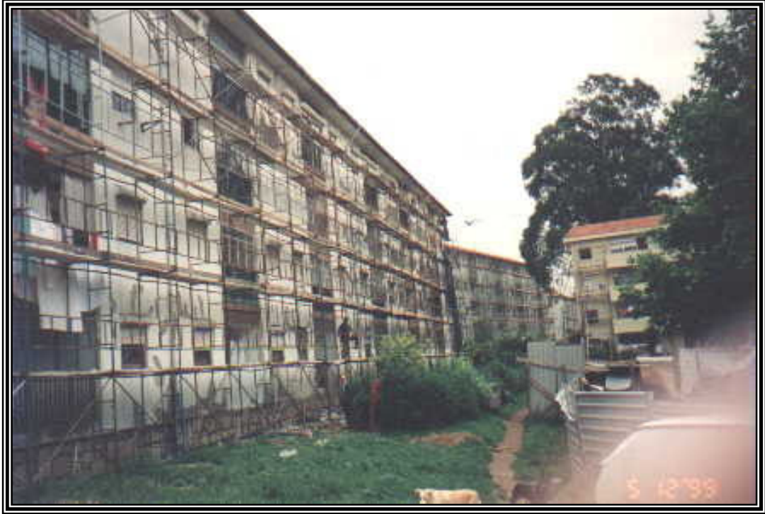
Fotografia 82 – Obras de recuperação no Bairro da Pasteleira
